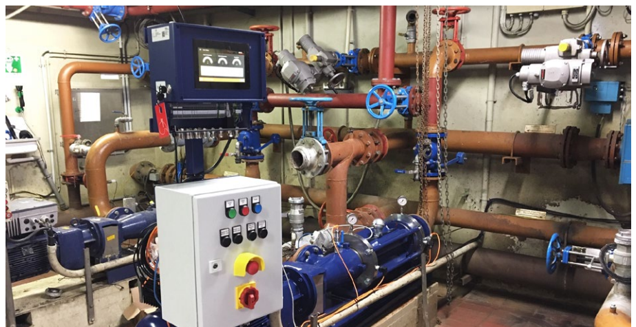
Installation der BN35-6LAS auf der Anlage, inklusive Pump Monitor.
