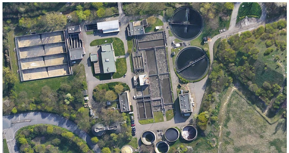
Kläranlage Gelsenkirchen Picksmühlenbach des Lippeverbandes (LV)
